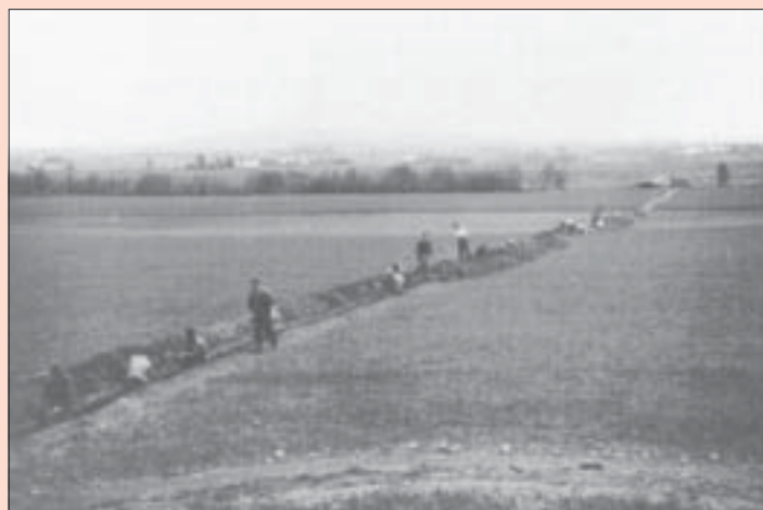
Grävning av kabelgravar vid batt HB
